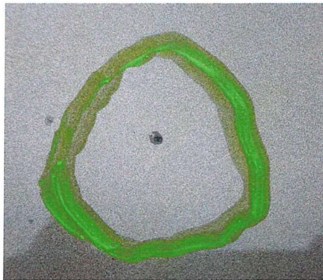
Bild 3: Punktueller Schädigung mit hofartig ausgeformter Unterwanderung (Probenahmeort, Probe 1)
