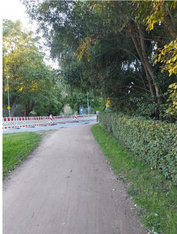
Gefährliche unübersichtliche Kurve sowie Rillen
